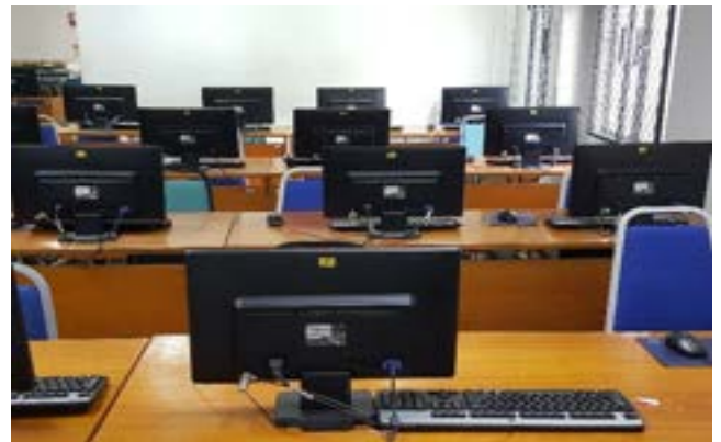
Pendawaian/kabel yang kemas dan selamat
