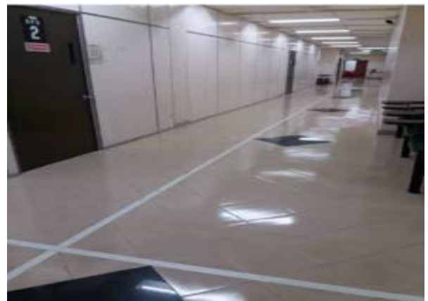
Lantai yang bersih, selamat dan tidak rosak
